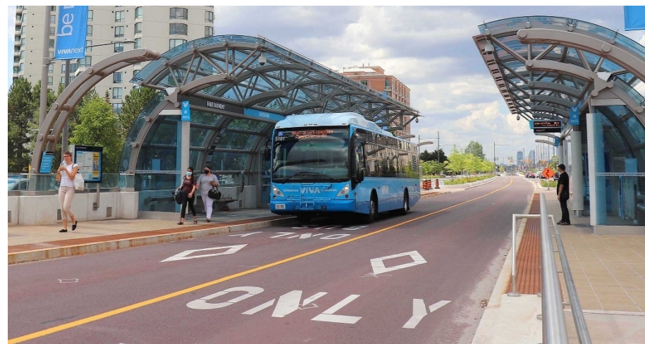
Busway examples: Top – G Line (LA Metro); J Line (LA Metro), Yonge Rapidway (York Region)
